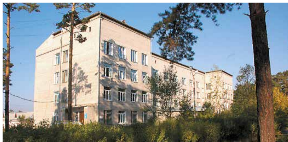
Здание ГУЗ ККВД
